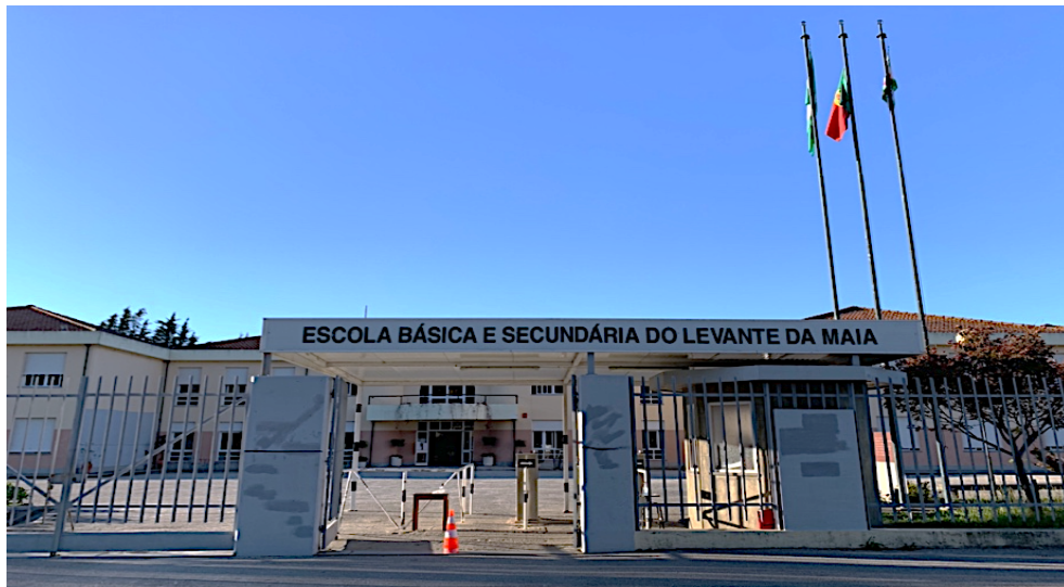
Figura 1 – Fachada da Escola Cooperante, Escola Básica e Secundária do Levante da Maia
