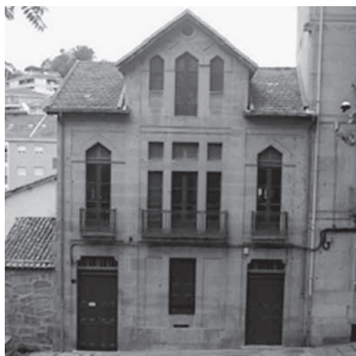
Fotografía da Casa de Baños do Outeiro
