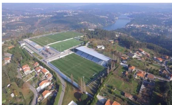
Figura 2 - Vista aérea do Centro de Treino e Formação Desportiva Porto Gaia.
