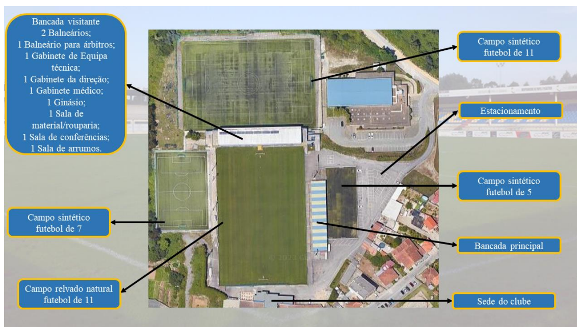
Figura 7 Complexo Desportivo Gondomar S.C.
