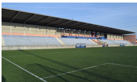
Figura 4.2 – Estádio Municipal de Nogueira
