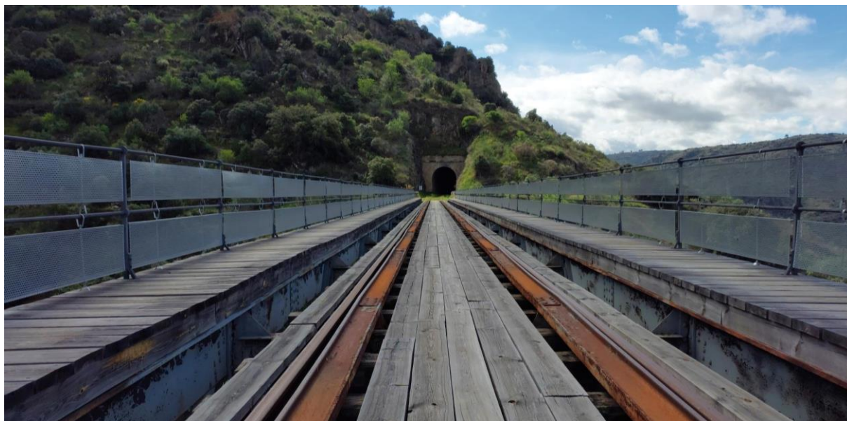
Figura 9 Ponte integrada na Rota dos Túneis.
