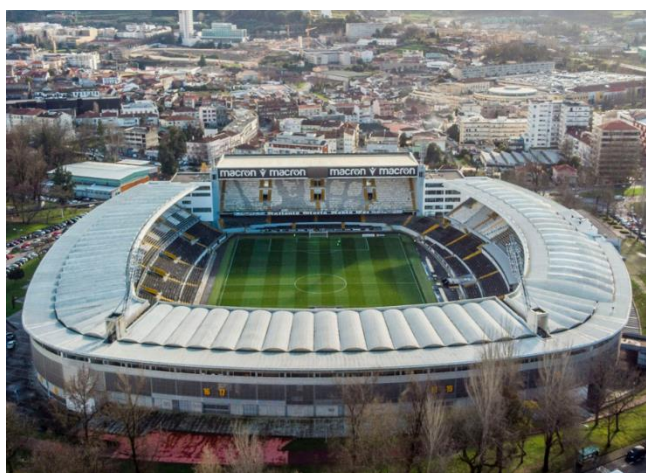
Figura 3 Estádio D. Afonso Henriques
