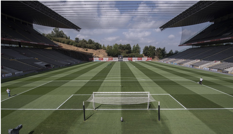
Figura 2 - Estádio Municipal de Braga
